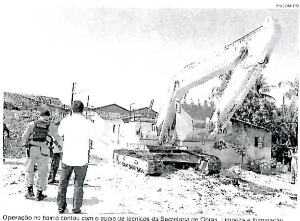
Operação no bairro contou com o apoio de técnicos da Secretaria de Obras, Limpeza e Iluminação
